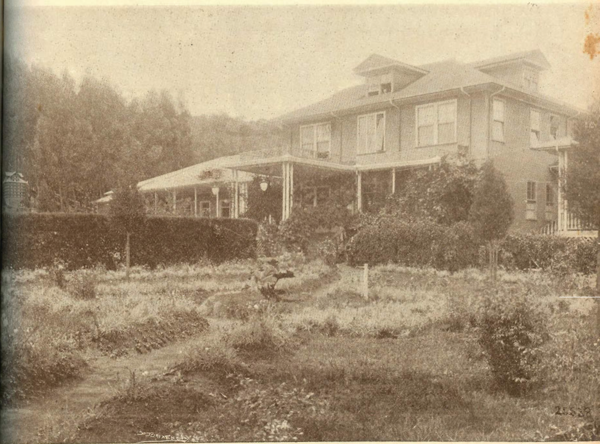
SANATORIO DURAN.--Vista del edificio principal y sus jardines.
